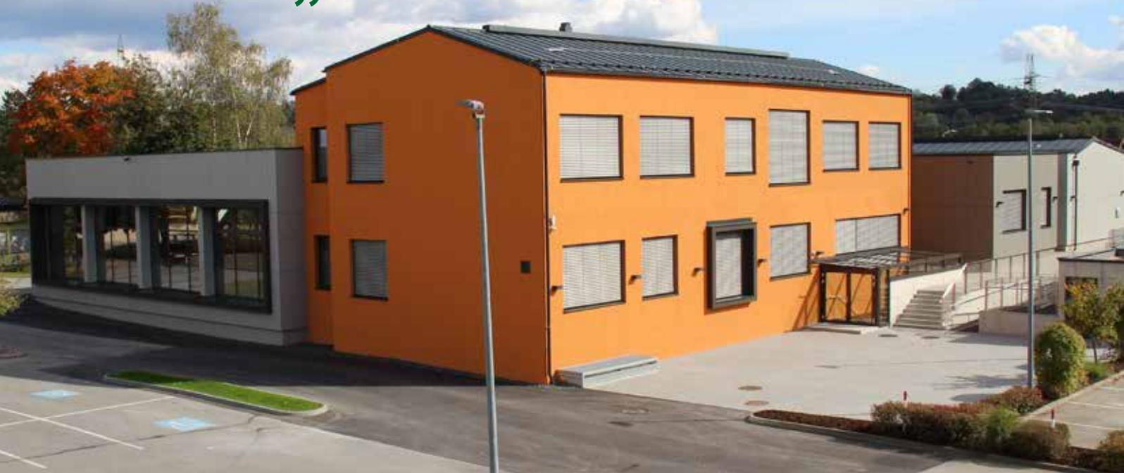
Unsere auf 8 Klassen ausgebaute Volksschule erstrahlt rundum im neuen Glanz. Neben dem Zubau (oranger Bauteil) wurde der gesamte Altbestand einer Generalsanierung unterzogen. Das gesamte Objekt wurde wärmegeklämmt und ist nun auch barrierefrei zugänglich. Die Teppichböden wurden durch Parkett oder Fliese ersetzt. Ebenso wurden alle Versorgungsleitungen
