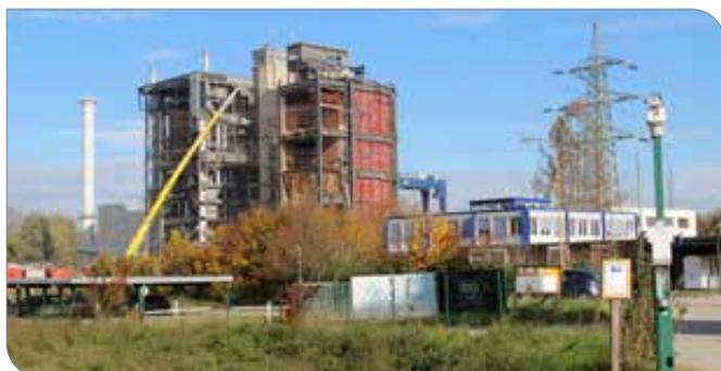
*Im November 2020 stehen nur mehr Teile vom Kraftwerksgebäude. Der Kamin und 3 der 4 Lagerkessel wurden bereits im Vorjahr abgetragen.*
