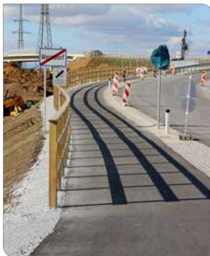
Am Bild links ersichtlich der Gehweg in beide Richtungen kombiniert mit dem Radweg in Richtung nach Werndorf. Der Radverkehr nach Wundschuh erfolgt über einen markierten Bereich auf der rechten Fahrbahnseite.
